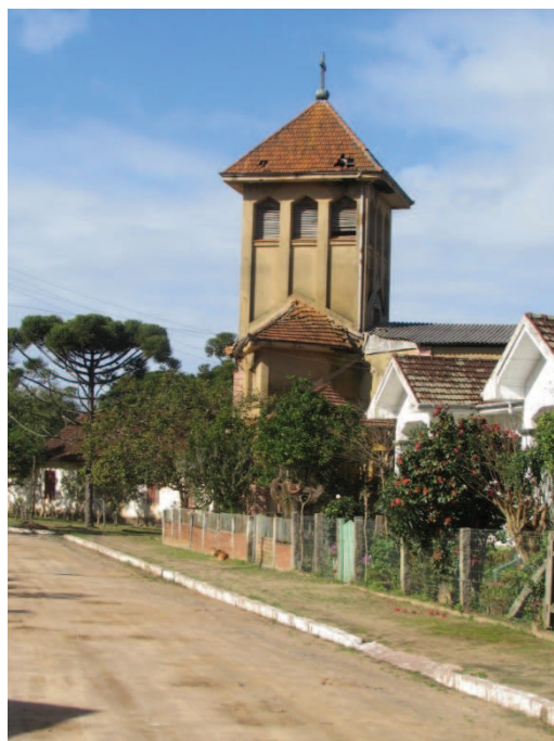
Figura 1: Visão da Casa dos moradores e da Antiga Igreja Evangélica
