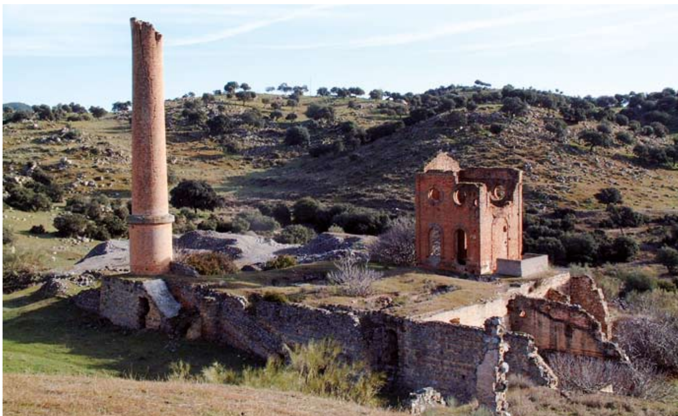
Fig. 7. French style "Bull" Engine House in San Andrés shaft (Guarromán) • Siłownia typu „Bull” we francuskim stylu nad szybem San Andrés (Guarromán)
