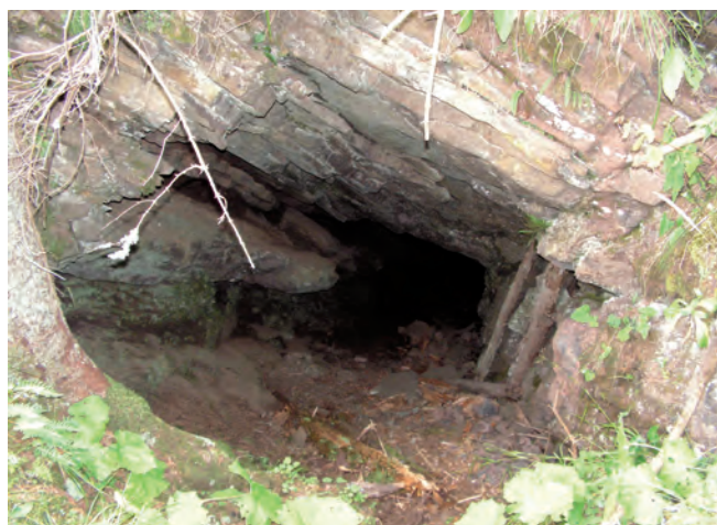
Fig. 4. The Huciańskie Banie 1 adit – entrance to the adit, phot. P. Gajowczyk • Sztolnia Huciańskie Banie 1 – wejście do sztolni, fot. P. Gajowczyk
