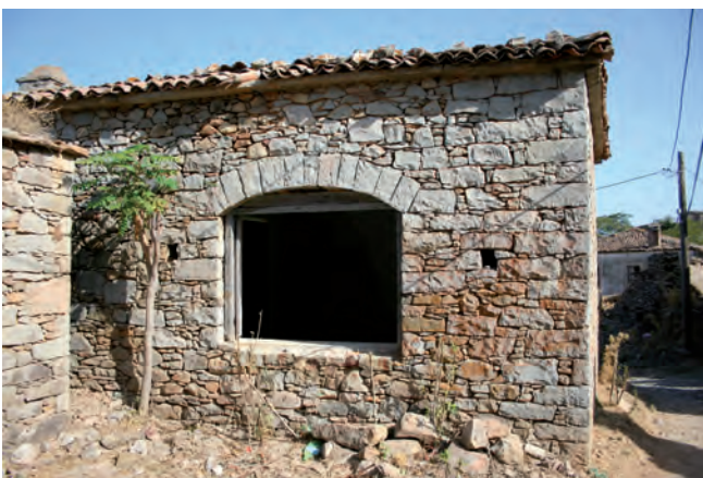
Fig. 5. Dereköy – building made from well fit blocks of andesite, phot. M.W. Lorenc • Dereköy – budynek wykonany z dobrze dopasowanych bloków andezytu, fot. M.W. Lorenc
