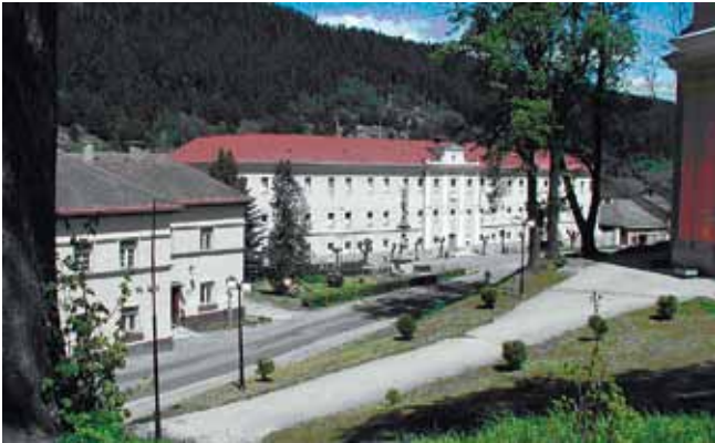
Fig. 9. The Kamerhof – the former seat of court chamber at Smolník destroyed by fire in 1880 and reconstructed into tobacco factory, photo T. Sasvári • Kamerhof – dawna siedziba sądu w Smolniku zniszczona przez pożar w roku 1880 i przebudowana na fabrykę tytoniową, fot. T. Sasvári
