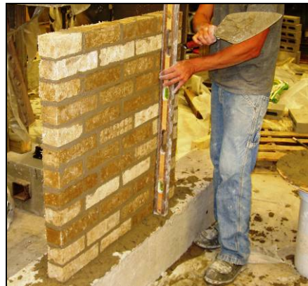
(d) Completed Wall
