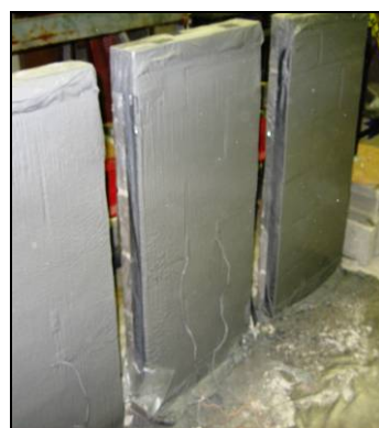
(d) Retrofitted URM Walls
