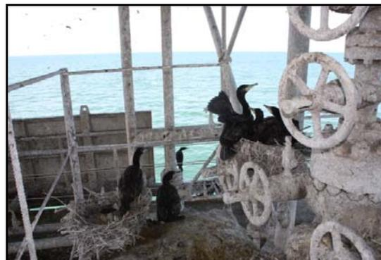
Рис. 6. Разрушение деталей газовой платформы Стрелка-5 из-за воздействия помета баклана
