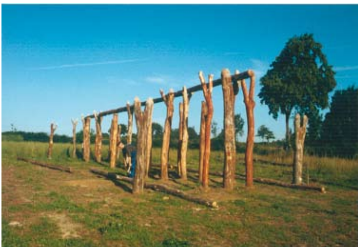
Abb. 3. Zuerst werden die tragenden Strukturen der Hausmodelle errichtet (hier beim Typ Pennigbüttel). Foto AÖZA, Albersdorf.
