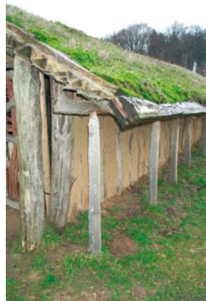
Abb. 4. Detail der Wand und des Daches des Hauses von Pennigbüttel. Foto AÖZA, Albersdorf.
