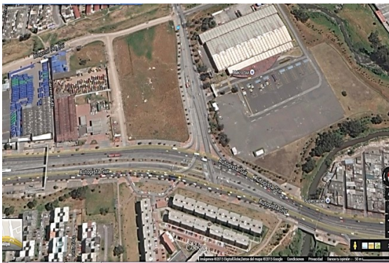
Figura N°1. Estado actual de la intersección
