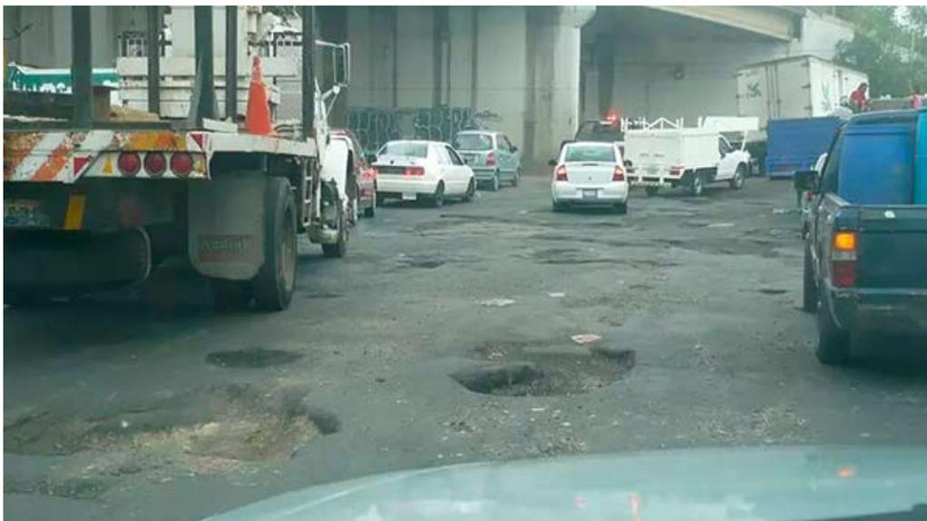
**Figura 9.** Grave deterioro de pavimento en la metrópoli de Guadalajara
