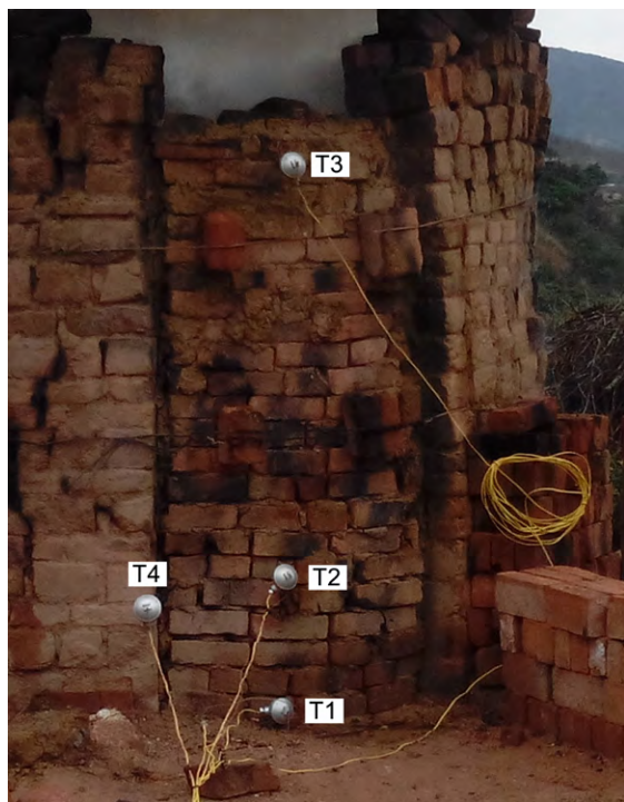
Figura 1. Termopares instalados por niveles en el horno
