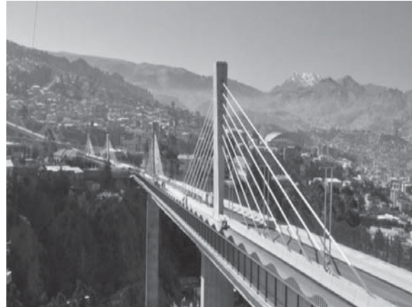
Figura 4. Puentes Los Trillizos en Bolivia.
