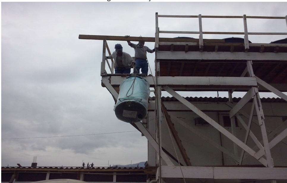
Figura 3: Elevação do boiler
