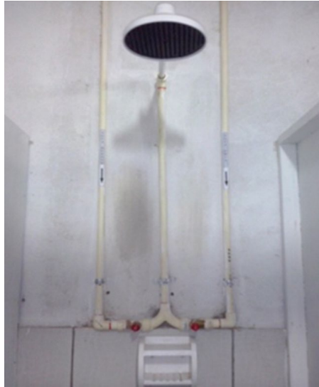
Figura 7: Instalação dos chuveiros
