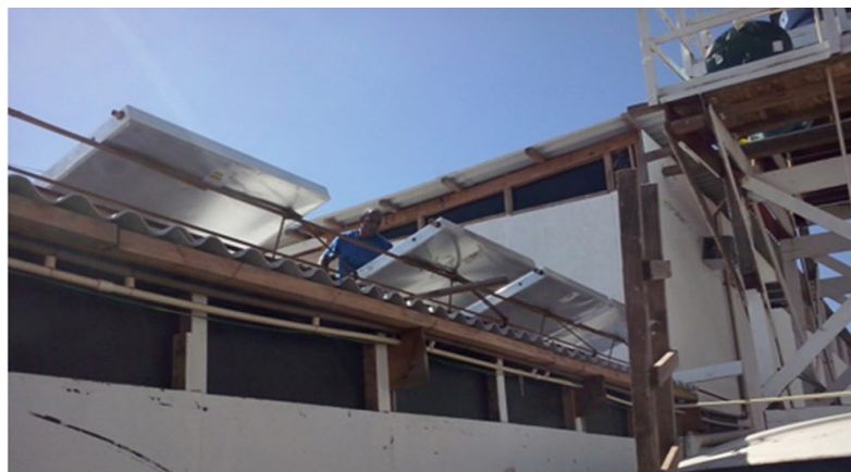
Figura 6: Instalação das placas
