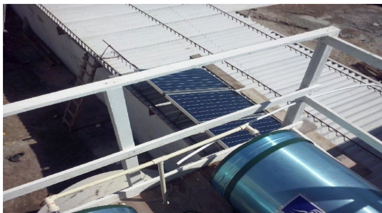
Figura 5: Instalação do boiler
