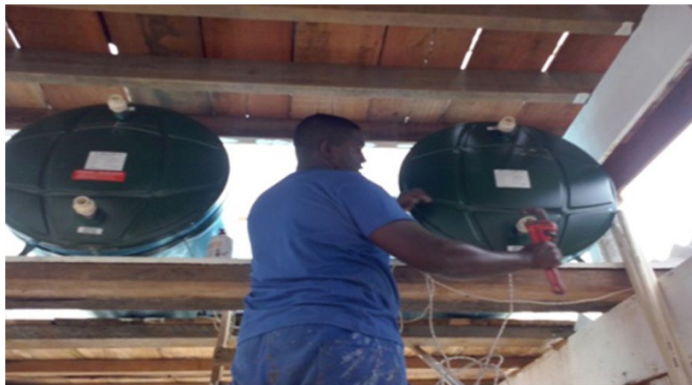
Figura 4: Instalação do boiler
