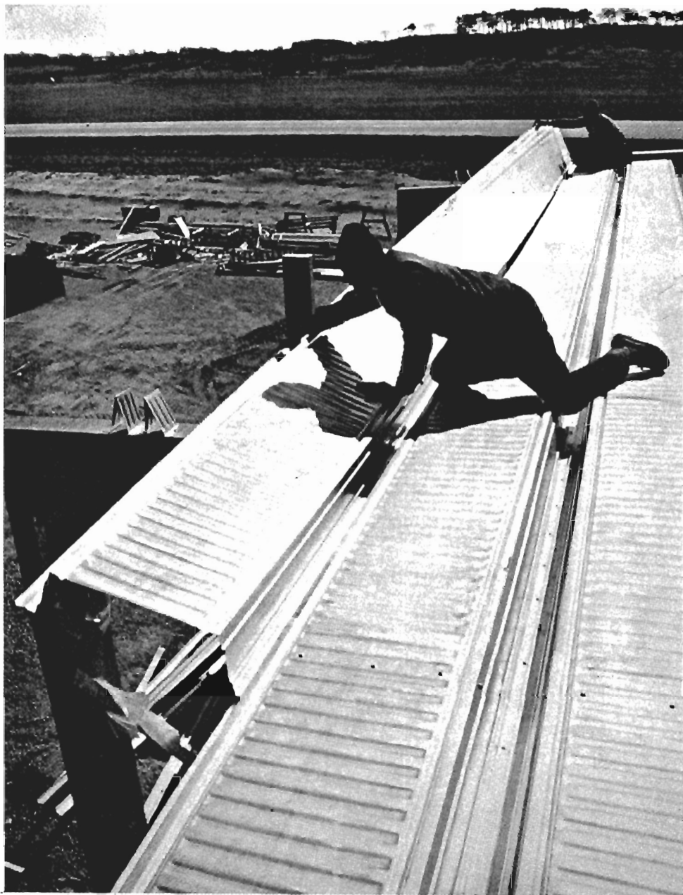
Fig. 3. TRP 200 Erection
