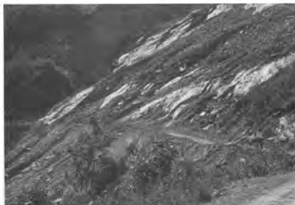
FIG. 9 Narak Landslide, Sikkim.
