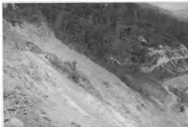
FIG. 8 Kumrek Landslide, Sikkim.
