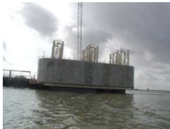
Fig. 47. View of Caisson (courtesy of Perry da Câmara)
