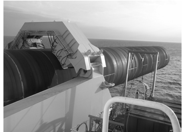
Fig. 10. 'Upending' the monopile
