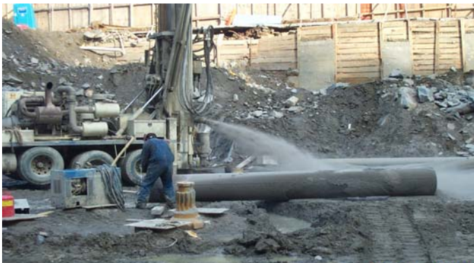
Fig. 6. Caisson Rig at NYT Tower
