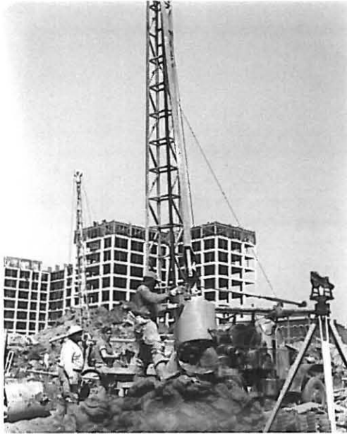
Fig. 15. 1950's era Bucket Rig.
