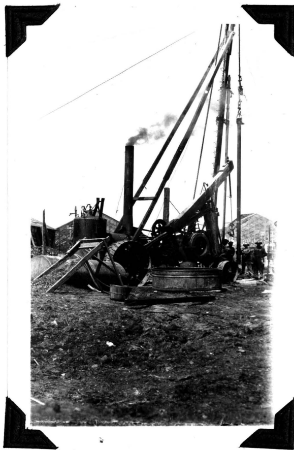
Fig. 5 Star drill rig.
