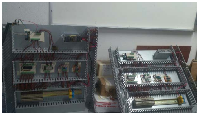
Fig. 13. Tableros construidos para los sistemas de adquisición de datos.
