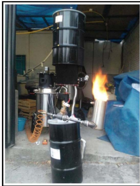
Figura 8 Fotografía del gasificador operando.
