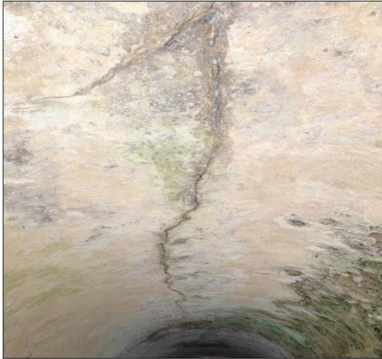
*Figura 4.57. Dettaglio della lesione individuata nel braccio Ovest.*
