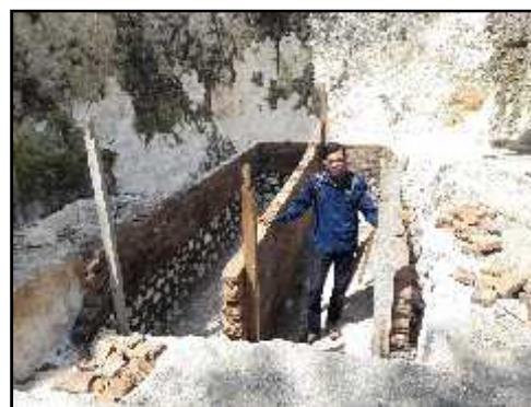
Gambar 6: Digester yang masih dalam tahap pembuatan di Desa Monggol
