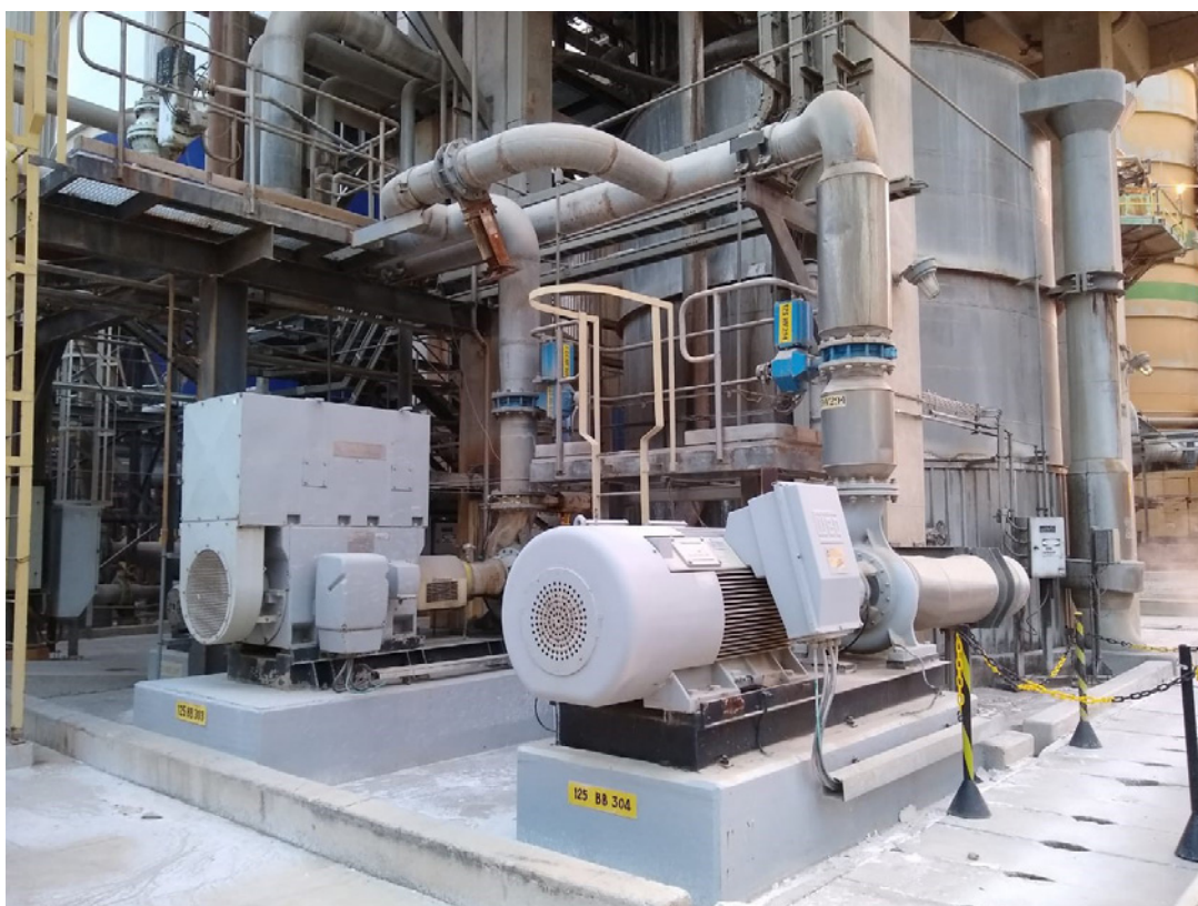
Figura 5. Instalação do by-pass e da nova bomba
