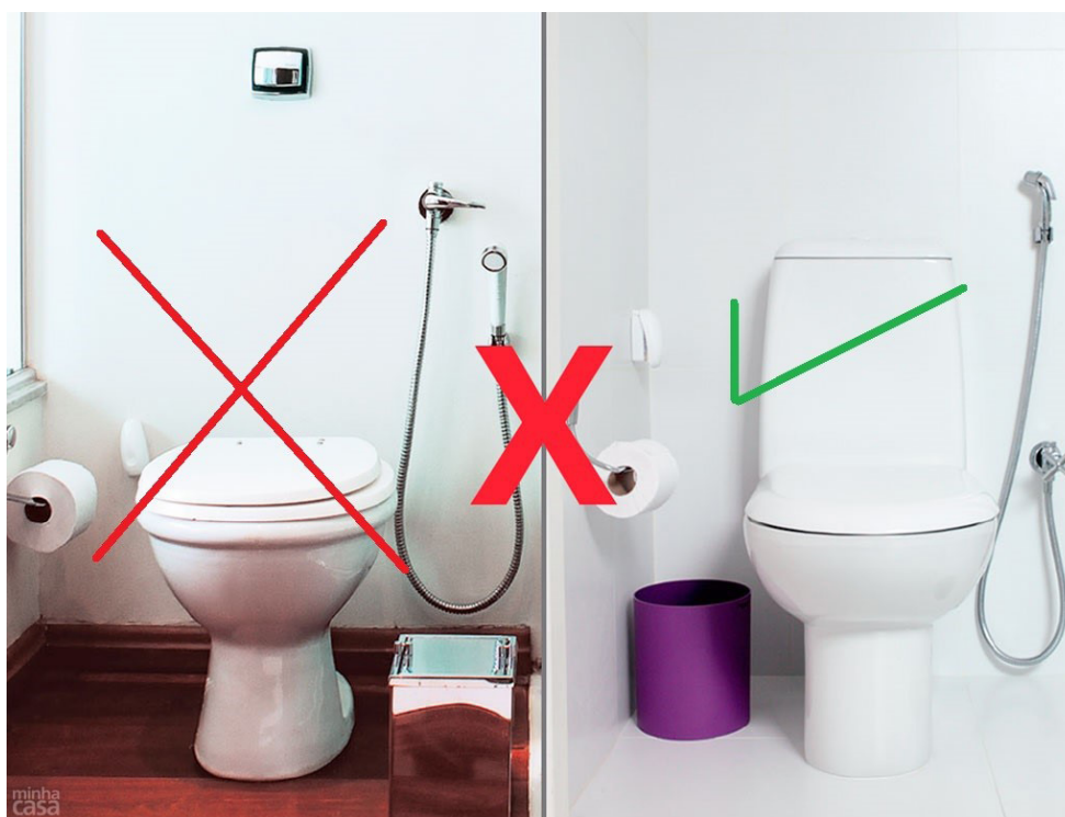
Figura 5. Tipo de vaso sanitário adequado para economia de água
