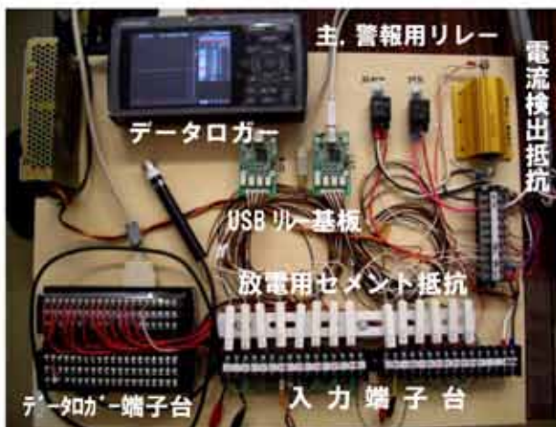
図4 BMSシステム外観写真
