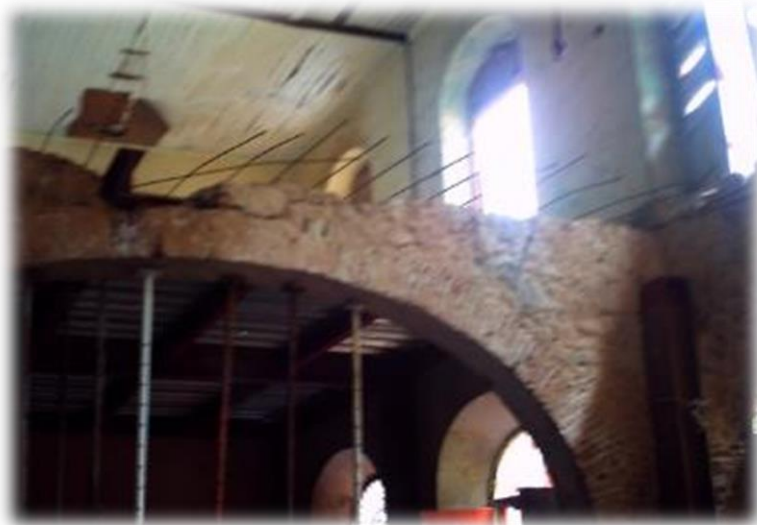
Figura 2 Espacio interior con arco carpanel de calicanto Fuente: Foto Cristian Méndez – D.N.P.H.,
