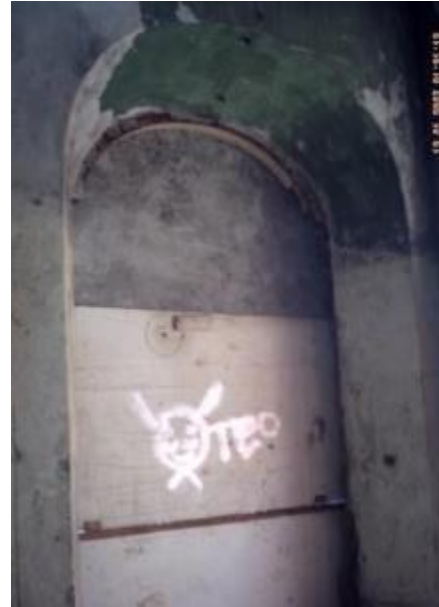
Figura 31 – Puerta tapeada y muro de calicanto pintado Fuente: Foto por Carmen Vásquez
