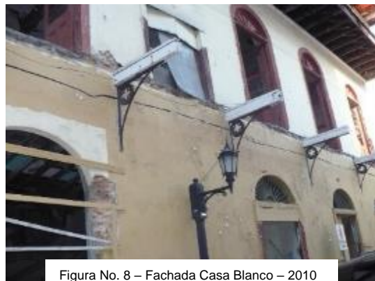
Figura No. 8 – Fachada Casa Blanco – 2010 Fuente: Foto Carmen Vásquez
