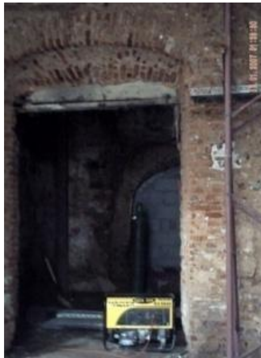
Figura 40: Muros y arcos de mampostería Foto por: Carmen Vásquez G., 2010
