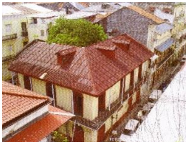
Figura 38: Edificio 32-8 - 2006 Fuente: Foto Cristian Méndez – 2006
