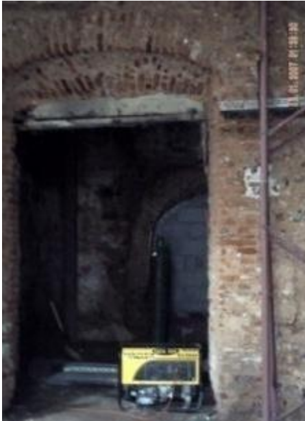
Figura 30 – Vano interior con dintel de mampostería con arco rebajado, sin puerta Fuente: Foto por Carmen Vásquez
