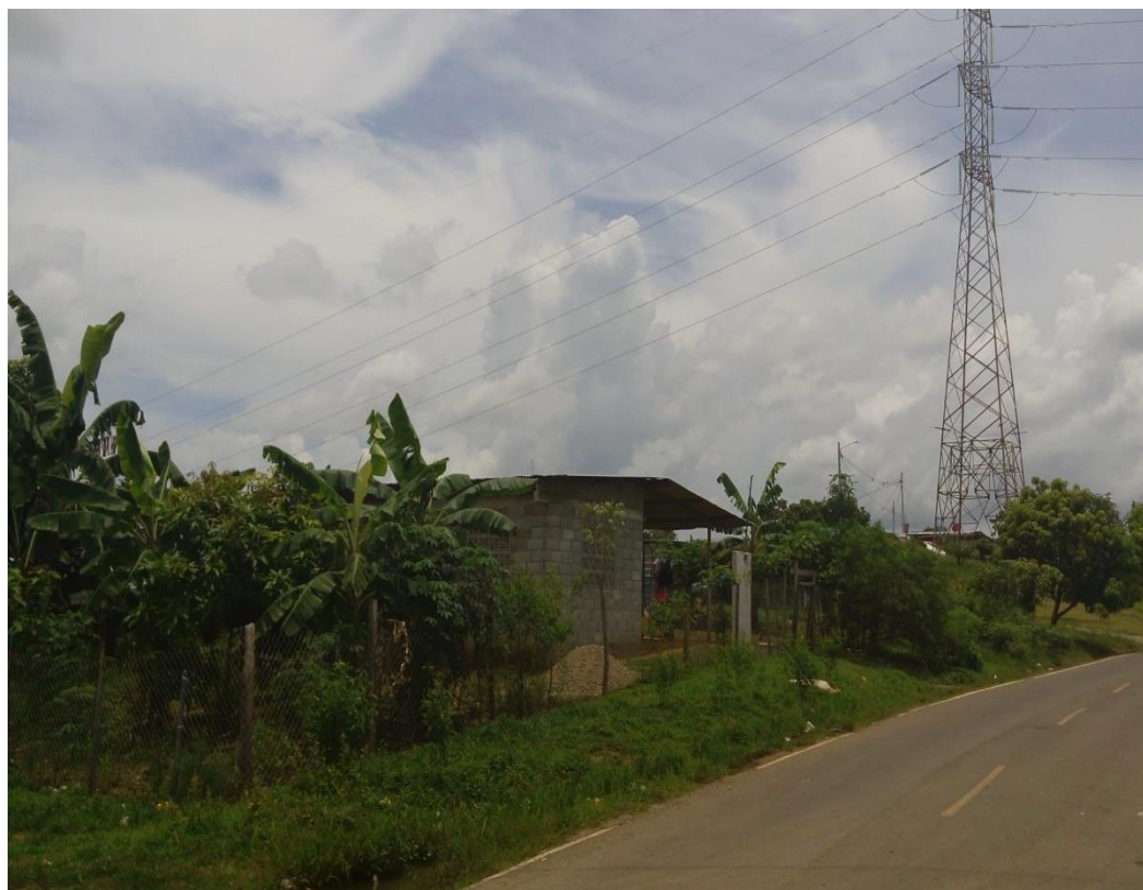
Ilustración 6. Tendido eléctrico en Unión de Azuero 2.
