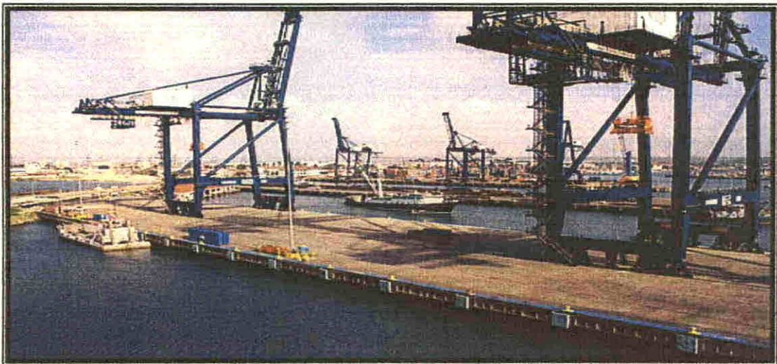
Figura 56 TERMINAL PORTUARIA DE CRISTÓBAL
