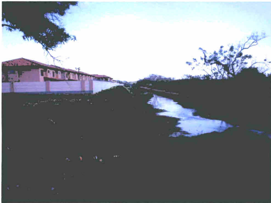
Figura 19: Canalización de la Quebrada La Gallinaza.
