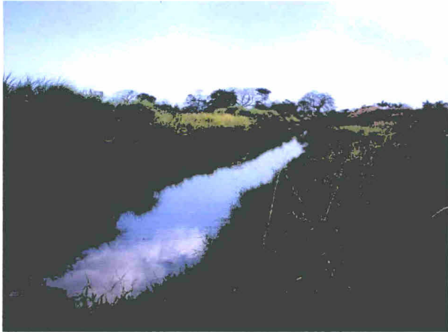
Figura 18: Canalización de Quebrada Sin nombre.
