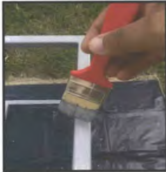
Foto propia 33. Recubrimiento de la base de hierro para proteger el material.
