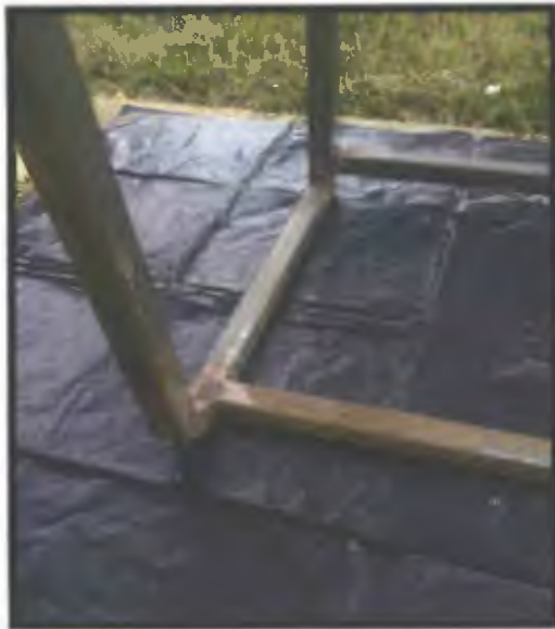
Foto propia 31. Detalle de la base de la banca de parque con tubos reciclados.
