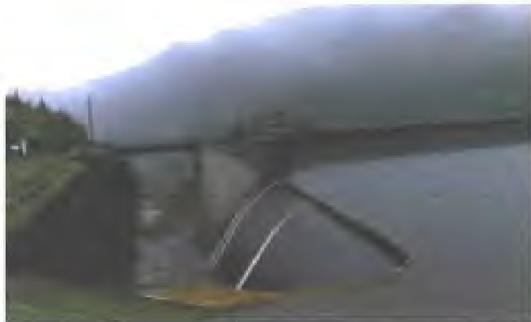
Fig. 1 Central Hidroeléctrica Edwin Fabrega, "Lago Fortuna" EISA.
