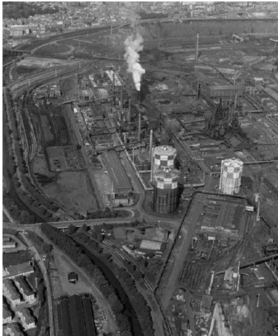
FIGURA 2. VISTA GENERAL DE LA FACTORÍA SIDERÚRGICA DE ENSIDESA ANTES DE SU DESMANTELAMIENTO
