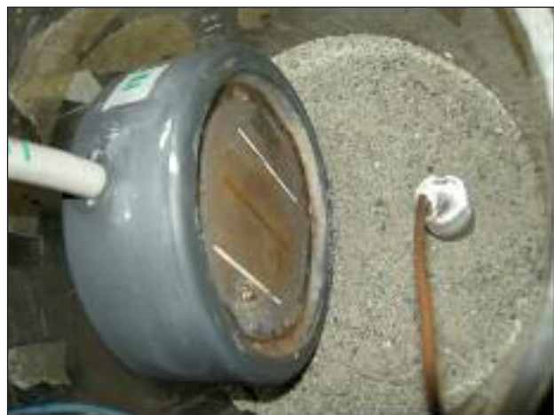
FIG. 6 Sonda e anodo di Mg.
