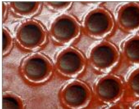
Fig. 21-22 Applicazione interno tubi. Application inside the tubes.
