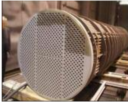
FIG. 19-20 Fase di sabbatura dello scambiatore.
