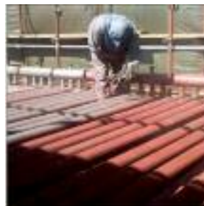
FIG. 9-10 Applicazione in cantiere su tubi alettati.
