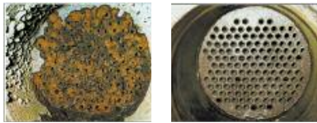
FIG. 16-17 Scambiatori operanti in parallelo per due anni, uno dei quali rivestito.
