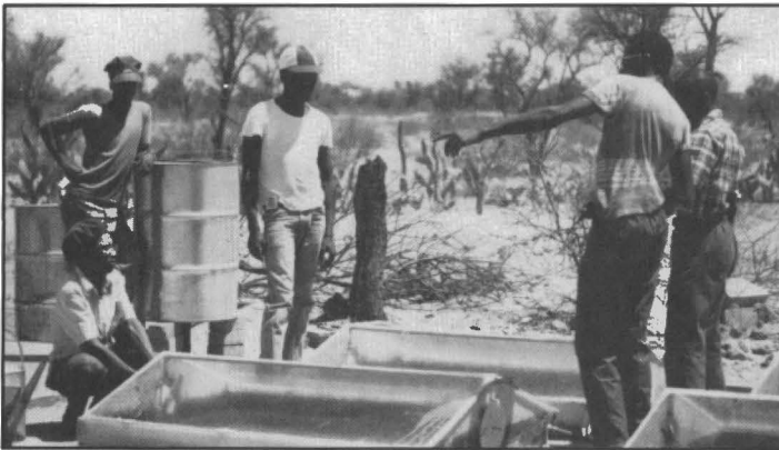
Assemblage de distillateurs solaires dans le désert du Kalahari, au Botswana.
