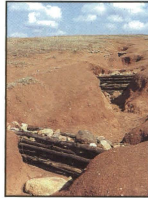
Barrages en pierre et rondin contre l'érosion au Swaziland.
