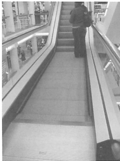
図4 ショッピングセンターの水平部分の長いエスカレーター
