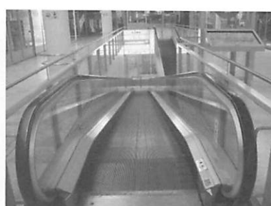
図18 ショッピングセンターの無段エスカレーター
