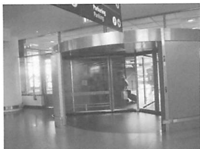
図7 空港ターミナル出入口の自動回転扉（かなり大きい）
