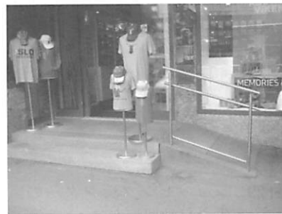
図23 小売店出入口には階段とともに手すり付スロープも設置されている
