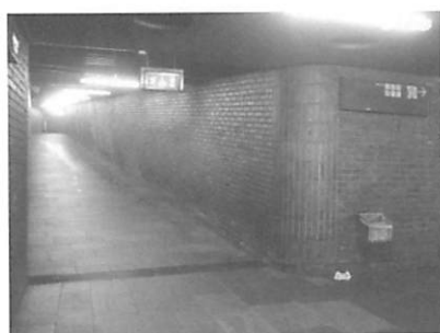
図19 地下鉄駅構内の移動はスロープが主な手段である
