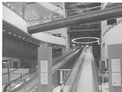
図 30 図書館にある無段緩勾配エスカレーター
