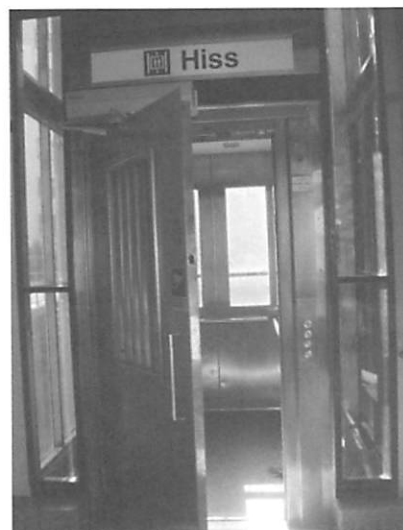
図10 地下鉄のエレベーターは押しボタン式手動片開き扉である
