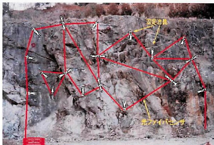
写真10.2.6 岩盤斜面への光ファイバセンサ敷設状況図
