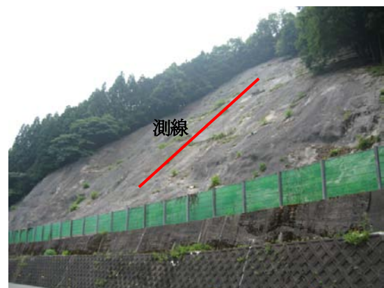
図-2 吹付け法面（A地区）
