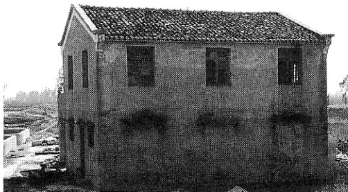
写真一六 海岸堤防背後の農家の浸水痕跡
