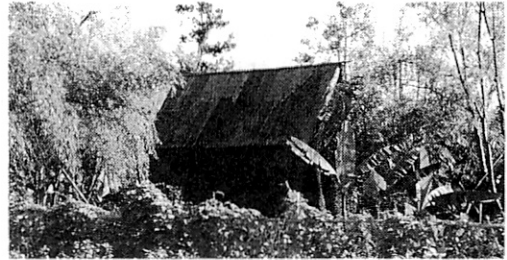
写真-3 下流側の小屋に残る浸水痕跡
