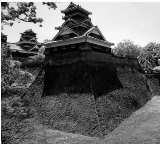
図 4 宇土櫓の被災状況
