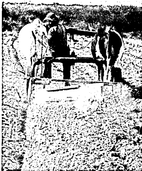
FIG. 8. Construção de um dreño usando lâmina enleiradora.
