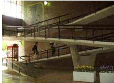
図 15 ピロティ内のスロープ
