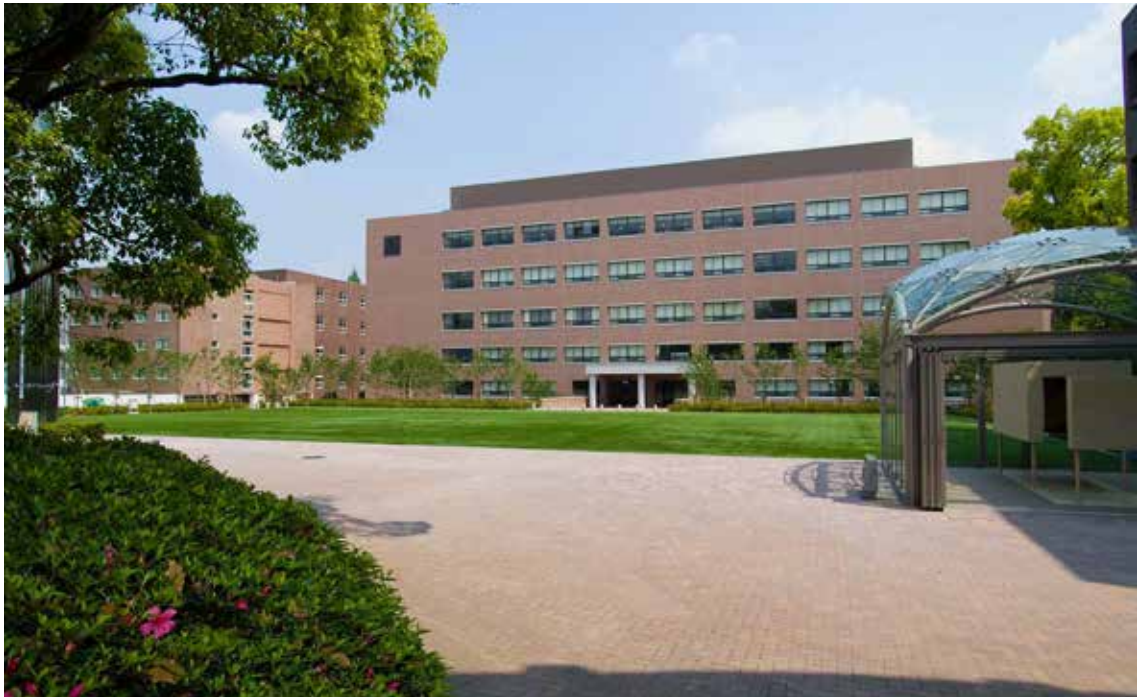
図 28 あすかの庭（第 1 学舎旧 1 号館所在地）と現 1 号館（2008）
