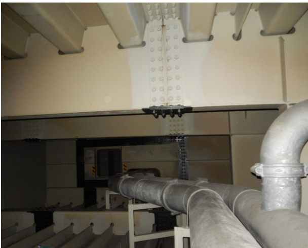
図1 鋼橋箱桁内部の様子
