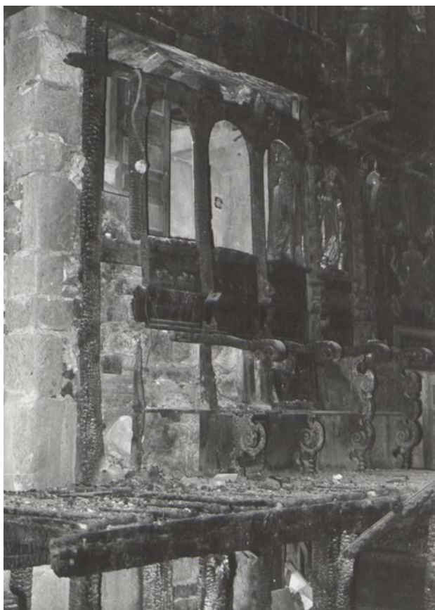
FIG. 4. Restos del coro de la catedral de México, tras el incendio de 1967 (AH 2354).
