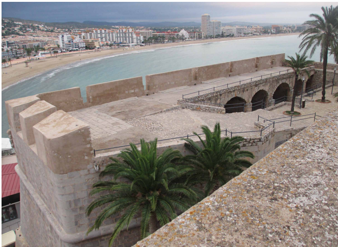
Fig. 6 Veduta delle fortificazioni di Peñiscola. L'immagine mostra una quota del cordone e dell'imposta degli archi conforme al trattato militare (rif. fig. 3).
