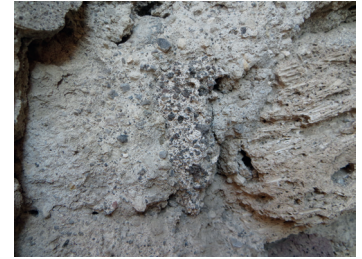
Fig. 13 Particolare della malta relativa al prospetto sud dello sperone del districtarium
