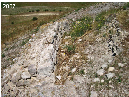
Fig.14 Scivolamento di un tratto di mura ovest attivato dal sisma di S. Giuliano di Puglia del 2002
