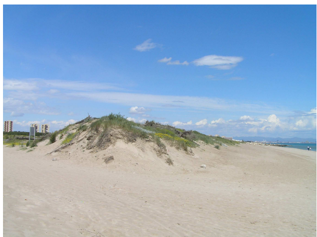
Figure 4, 5. Il progetto di recupero della Devesa nel Parque Natural de la Albufera: sopra (fig. 4) la demolizione delle infrastrutture lungo il litorale (il "paseo marítimo"); sotto (fig. 5) il fronte dunale ripristinato.
